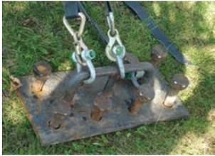
Bodenplatten und Erdnägeln mit einer Länge von jeweils 1,00 Meter. Hierzu muss anhand von Erdleitungsplänen geprüft werden, ob Erdleitungen im betreffenden Bereich vorhanden sind.
