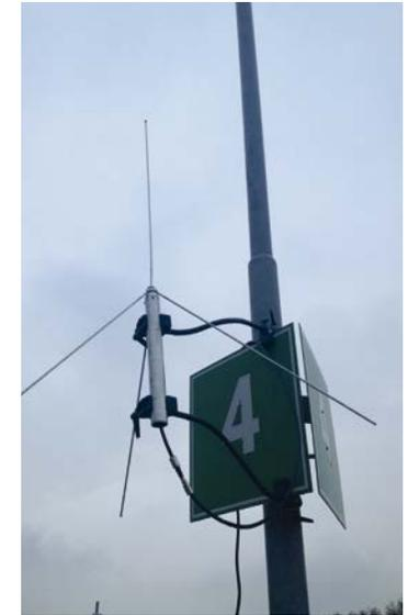
Die Tonübertragung im Autokino erfolgt längst nicht mehr über Standlautsprecher, die umständlich ins Auto gegangen werden müssen. Der Ton wird über ein Ukw-Funksignal direkt in die Autoradios übertragen. Durch eine digitale Tonabstimmung im Filmprojektor haben Sie eine perfekte Tonqualität in Kinoformat.
