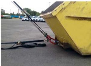
Auflastgewichte und Ballasttanks dienen der sicheren Befestigung auf asphaltierten Plätzen.
