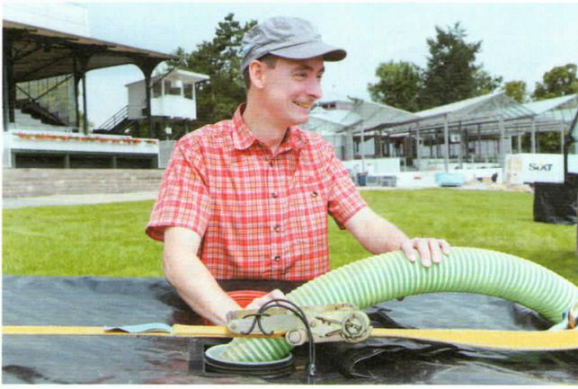
**Michael Woll** füllt einen der insgesamt vier IBC-Tanks mit Wasser, Gurte sind oben wie unten an allen vier Ecken des Leinwandrahmens angebracht, so dass insgesamt acht Verbindungen (4 × vorne, 4 × hinten) herzustellen sind
